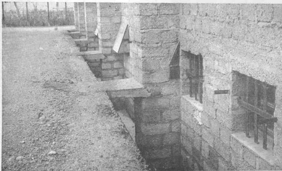
Fenêtres occultées du Bunker.
